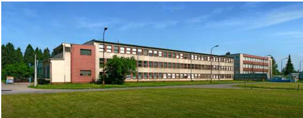
Obr. 1.1 Střední škola technická Žďár nad Sázavou
